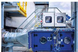
Régulation de la pression dynamique / psychrométrie / température / débit d'air / TRA\* dans les centrales de traitement d'air et les gaines
